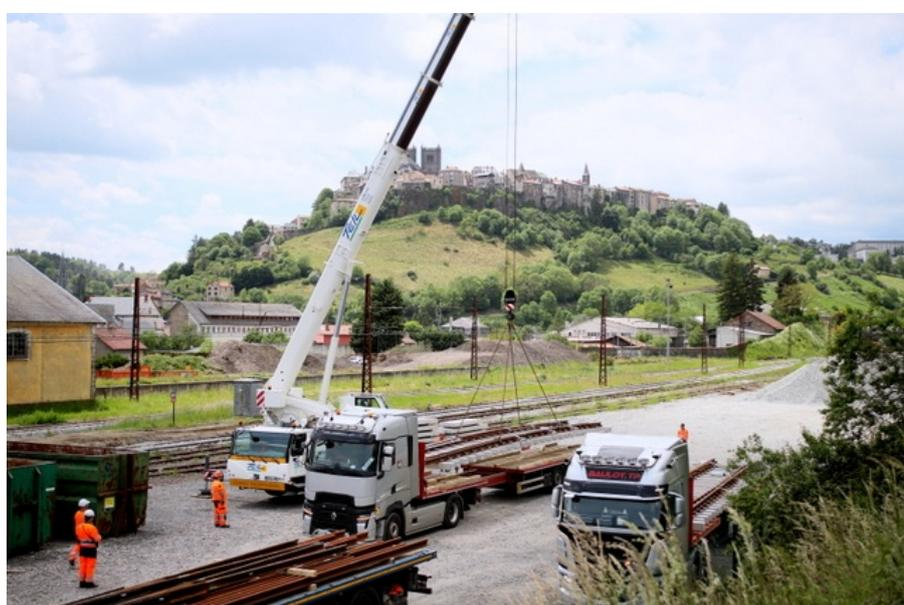
Les appareils de voies sont livrés déjà montés.
