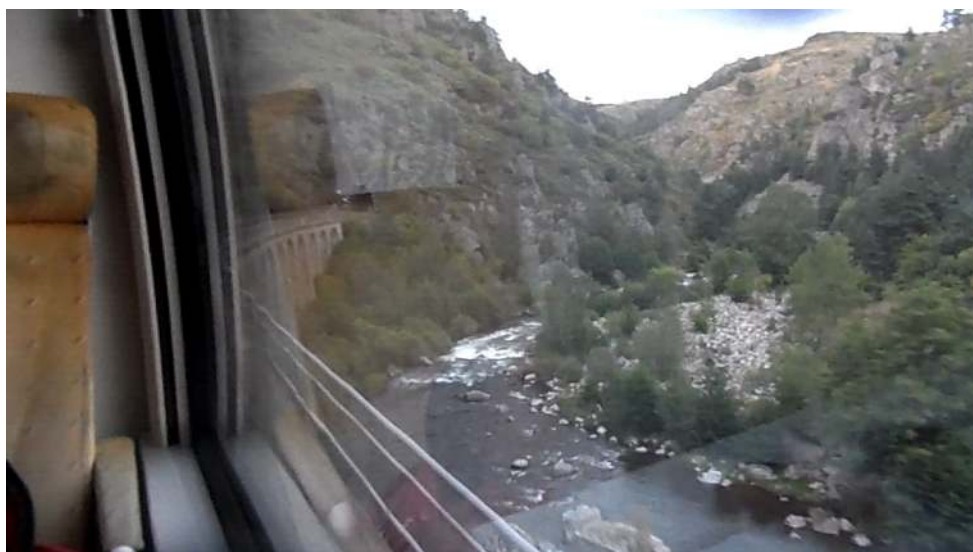
Franchissement d'un ouvrage d'art dans les Cévennes, à proximité de Chapeauroux.
