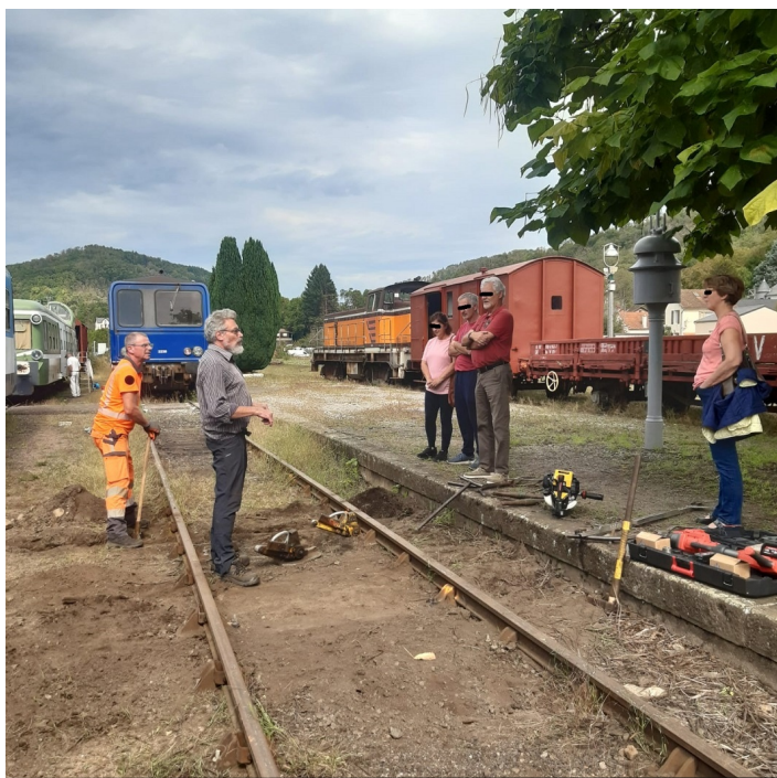
Démonstration de changement de traverses. Crédit photo Bruno CFHA
