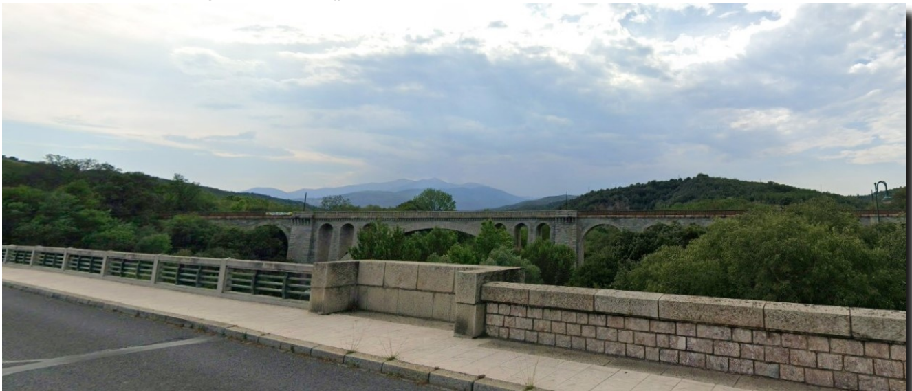
Le viaduc ferroviaire sur le Tech, vu du pont routier, ne pourra être réhabilité sans grever le coût de la remise en fonction de la ligne
