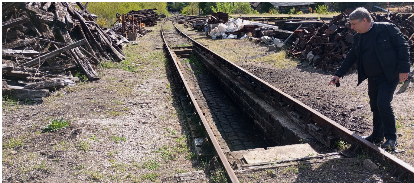
La fosse à piquer en gare de Bort. Vestige des temps anciens.
